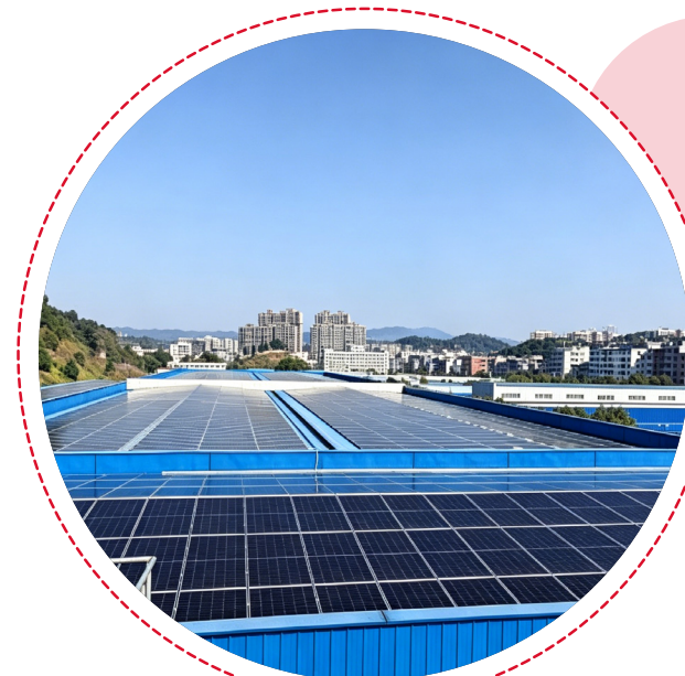
定南大华光伏发电建设项目
