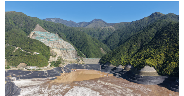
凉山稀土牦牛坪稀土矿瓦都沟尾矿库
