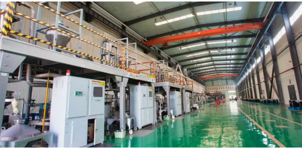
储氢材料生产线
